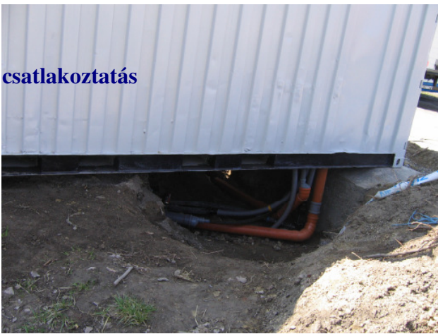
víz-visszaforgatás bekötése
